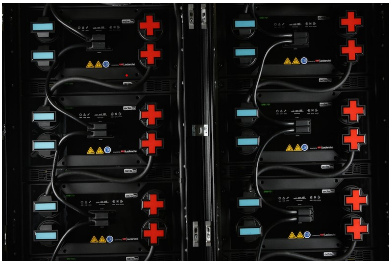
Figura 4.3: sistema di batterie al litio-titanato installato nella microrete dell'EPFL. [18]
